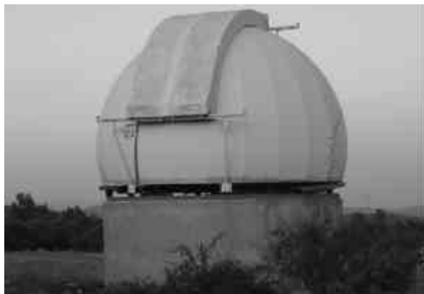
Le soubassement en bois a été ôté. Le dôme repose sur des cales
