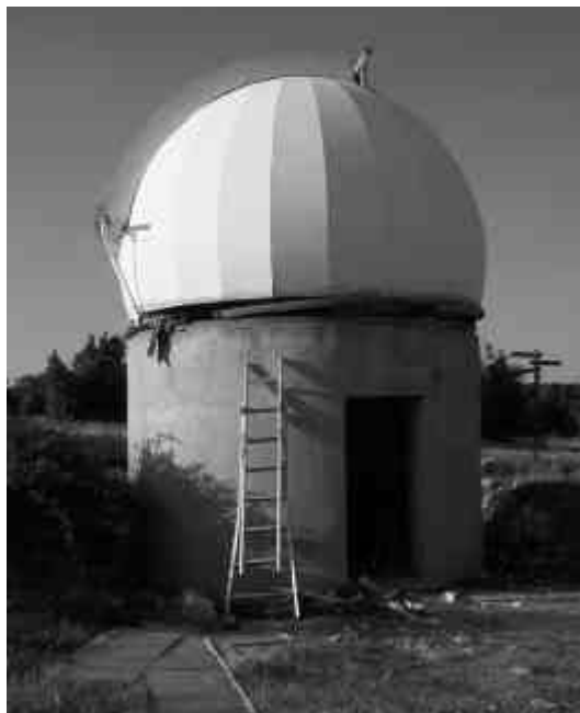
Intervention lourde sur la coupole
