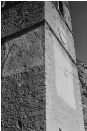
Les Vigneaux, église Saint Laurent, sur deux façades
