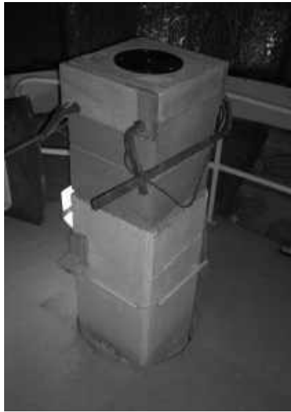
La chape de béton en travaux, qui réhaussera la colonne du C14
