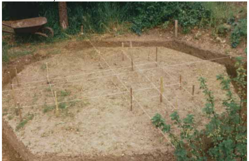
Traçage des fondations pour les piliers supportant le télescope ainsi que celles de l'abri (pelle, pioche, barre à mine...).
