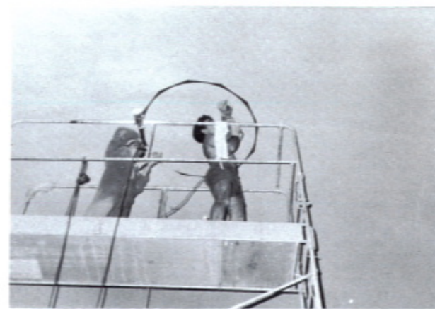
Pose de la dernière plaque.
