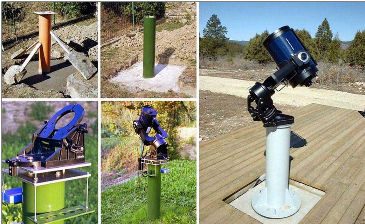
Figura 1- Exemplo de dois pilares idealizados para suportarem telescópios Meade LX200.
